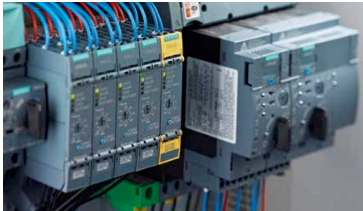
Los nuevos contactores electrónicos son polivalentes y completan de forma óptima la gama de productos SIRIUS actual.
